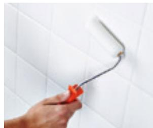
2. Arbeitsgang: Lassen Sie den Fliesenlack 10–12 Stunden trocknen, danach tragen Sie eine weitere Schicht auf. Benutzen Sie eine neue Schaumstoffrolle und tragen Sie den Fliesenlack gleichmäßig auf der gesamten Fläche auf (ohne separaten Fugenvoranstrich). Lassen Sie die zweite Beschichtung ca. 10–12 Stunden trocknen.
